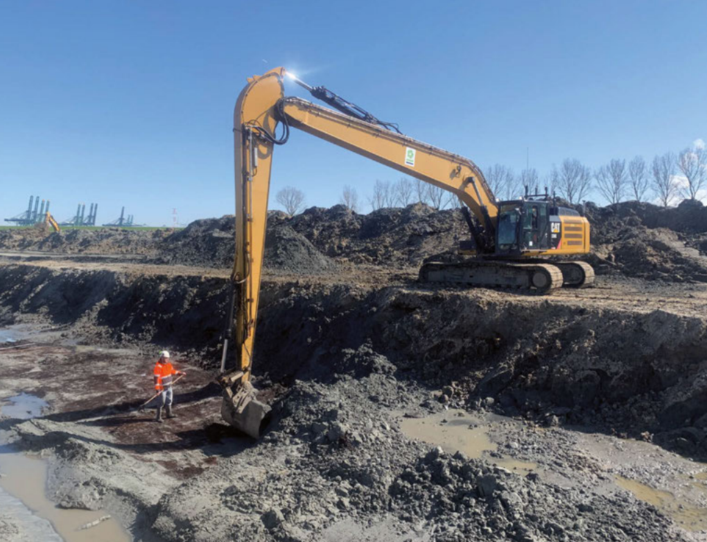
Graafwerkzaamheden hoofdgeul en archeologie | Foto: Anita Eijlers
